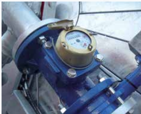
Auf den Spuleneintritt geflanschter Literzähler:
